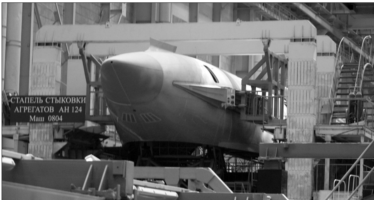
Стапель стыковки агрегатов Ан-124 № 08-04 и фрагмент хвостовой части фюзеляжа
