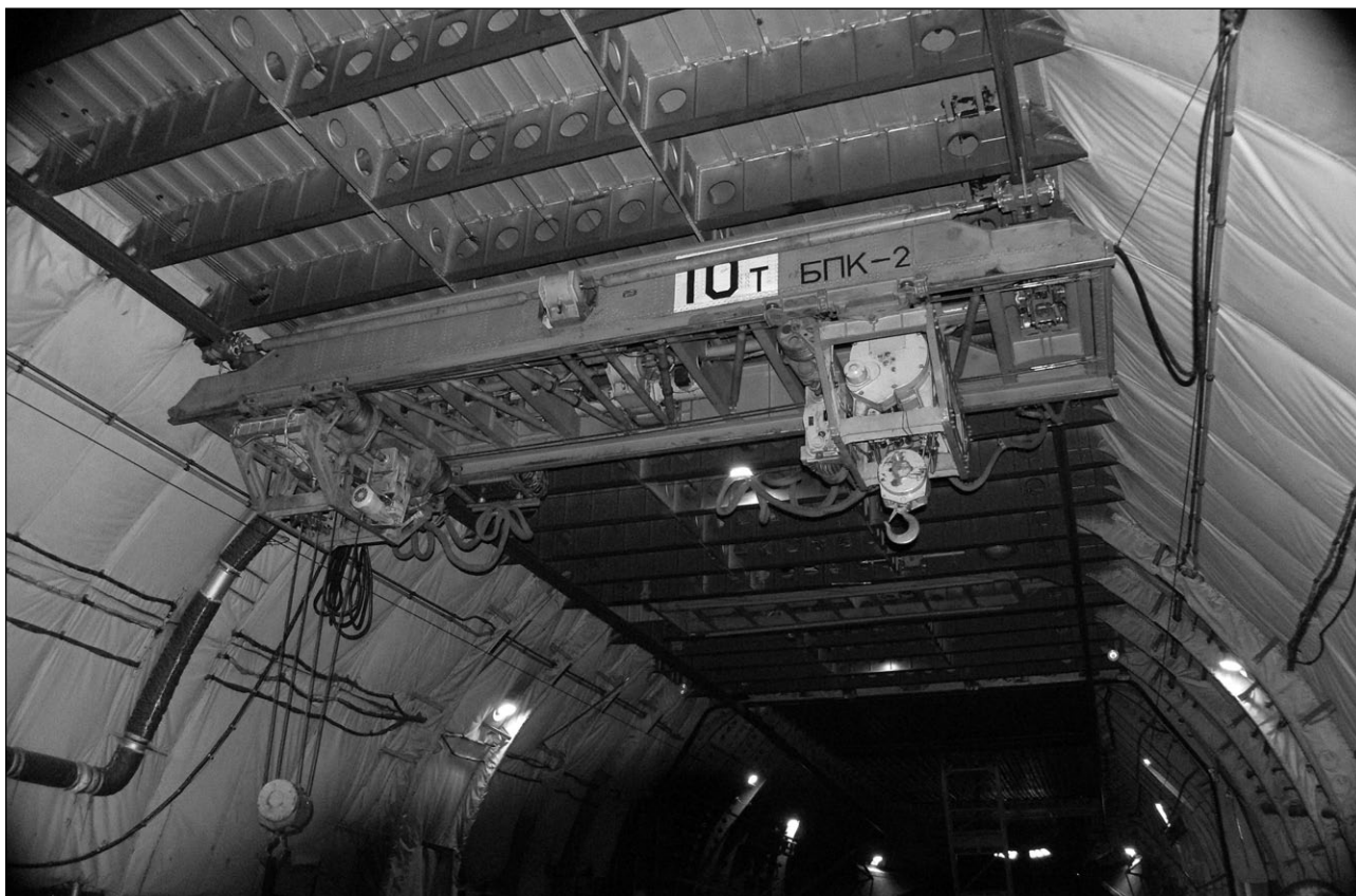
Подъемный кран БПК-2 грузоподъемностью 10 тонн
