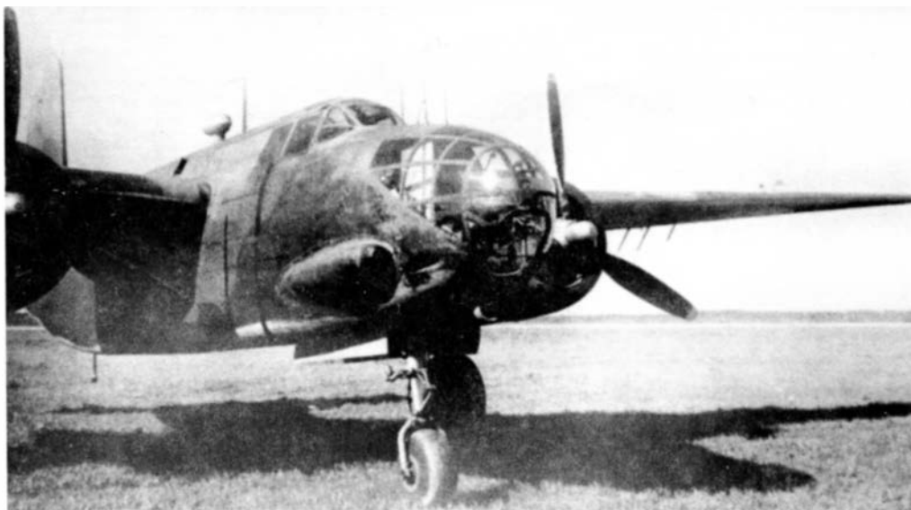
Б-3, оборудованный советской РЛС «Гнейс-2», во время испытаний в НИИ ВВС, аэродром Кольцово, 1943 г.
