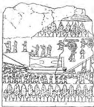
Транспортировка волоком гигантской каменной статуи крылатого быка.
