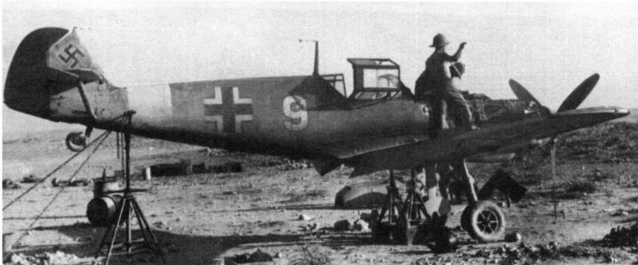
Пристрелка оружия на истребителе Bf 109E-4/N, отличавшегося от основной серии мотором DB 601N. Всего было изготовлено 20 таких машин
