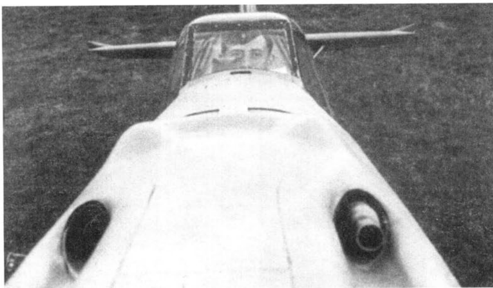
Фонарь кабины «мессера» почти все пилоты считали очень тесным. На фото хорошо видно, что летчик практически упирался в верхнее стекло головой, а пространство слева и справа от нее не превышало 15—20 см
