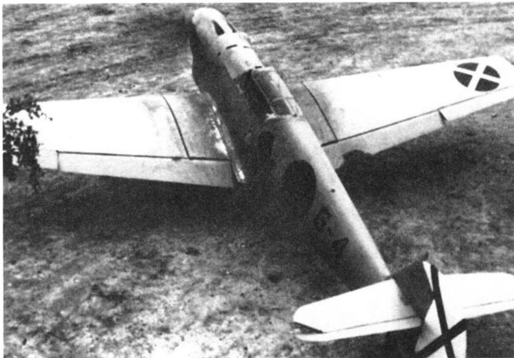
Второй серийный Bf 109B-1 в Испании. Видны закрылки и предкрылки большого размаха, «котелок» на борту
