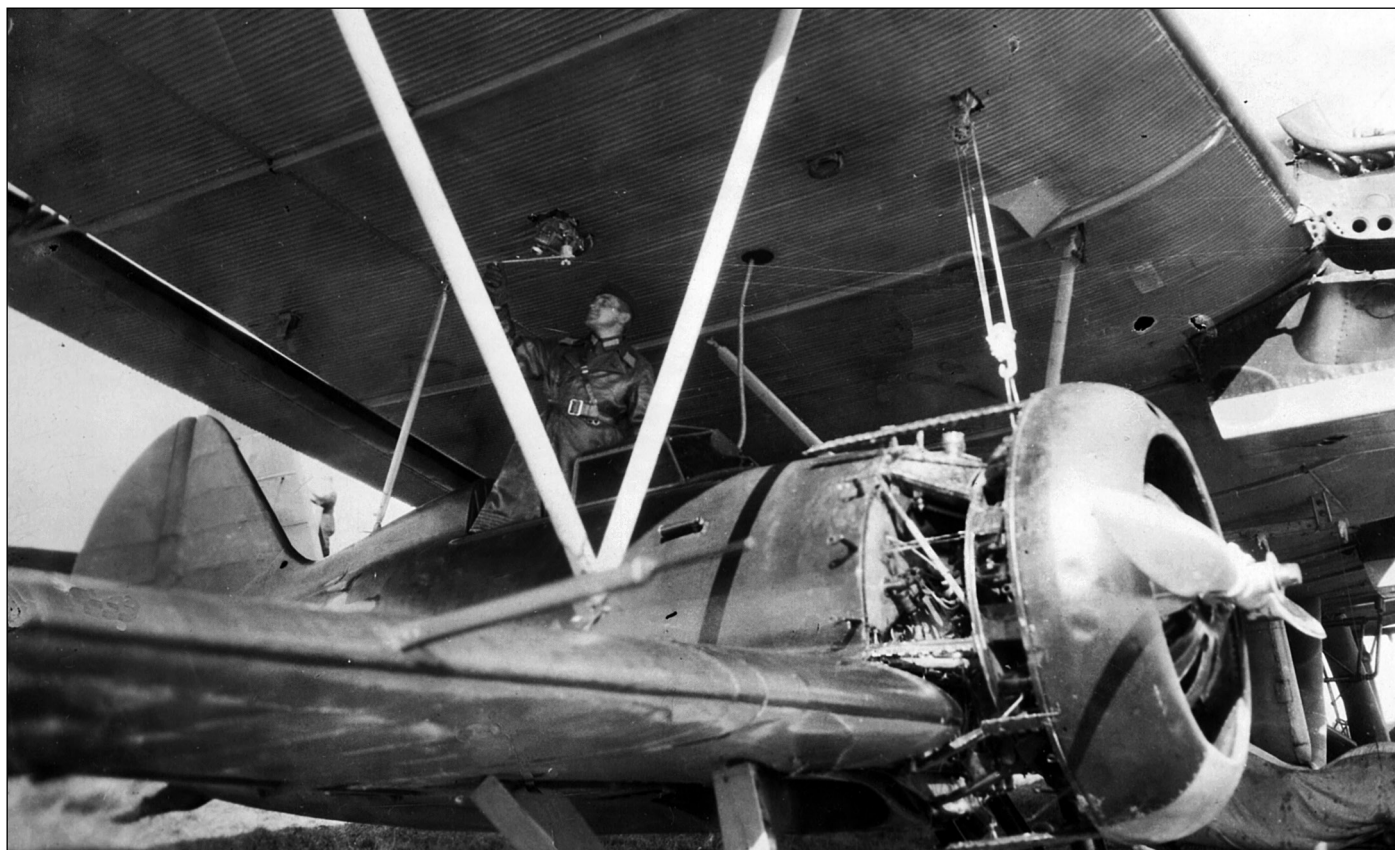
Подтягивание носовой части И-16 при помощи лебедки БЛ-3 перед установкой на крыльевые замки. На истребителе присутствует только лобовая часть капота. Из нижней поверхности крыла ТБ-3 протянут гибкий шланг для питания И-16 бензином во время совместного полета
