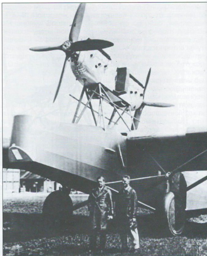
АС-3 после модернизации мотоустановки. Обратите внимание на четырехлопастные винты
