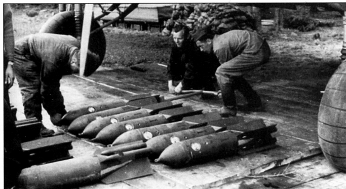
Оружейники готовят к боевому вылету бомбардировщик He.111H-3 из 1/KG27. В боевую зарядку самолета входят фугасные бомбы SC250 со свистками («Иерихонскими трубами») на стабилизаторах. (M. Griehl German Bombers Over Russia)
