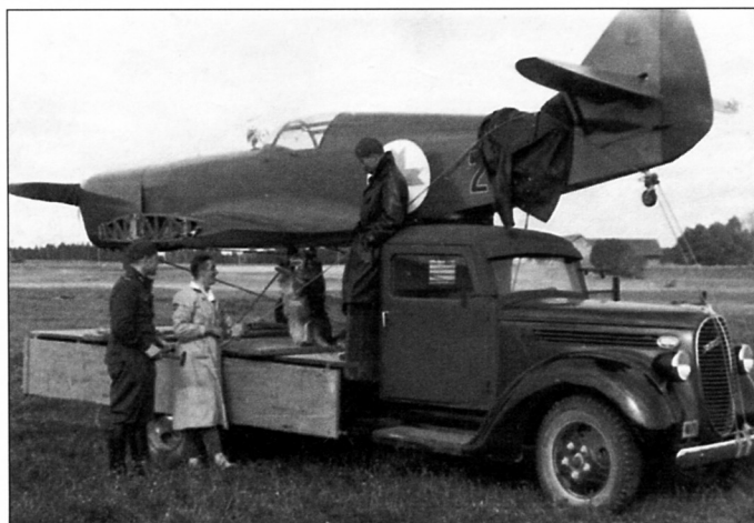
Одноместный вариант тренировочного самолета VEF I-12 Авиации айзсаргов с отстыкованными консолями крыла в кузове грузовика «Форд-Вайрог». В центре — конструктор инженер К. Ирбитис. Аэродром Спилве
