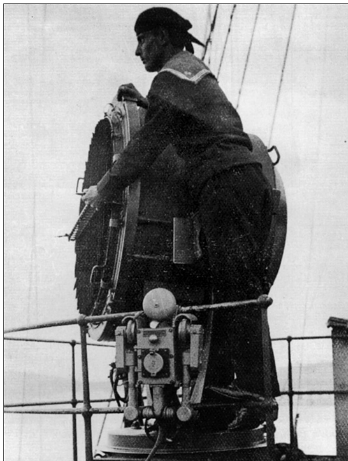
90-см прожектор крейсера «Адмирал Шпаун». Всего на корабле стояло три таких прожектора: два на носовой надстройке, один — на кормовой
