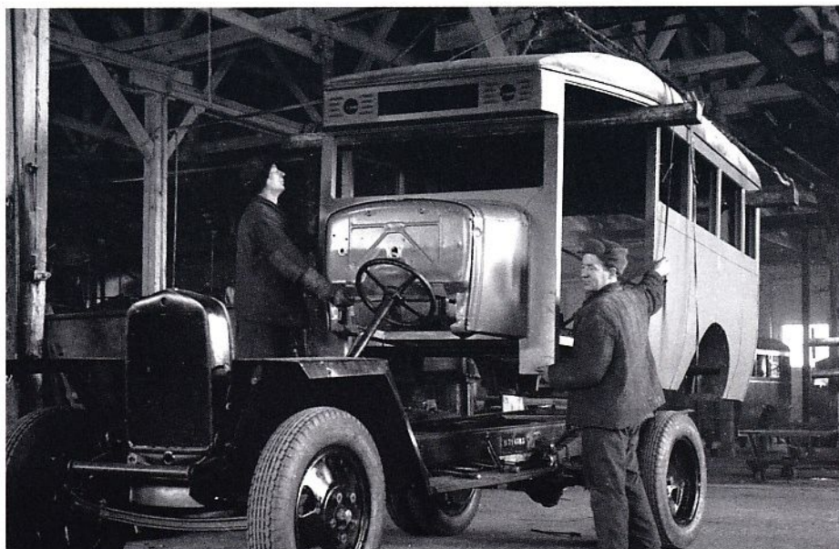
Установка кузова автобуса в Канавино на полученное с основной территории ГАЗа шасси
