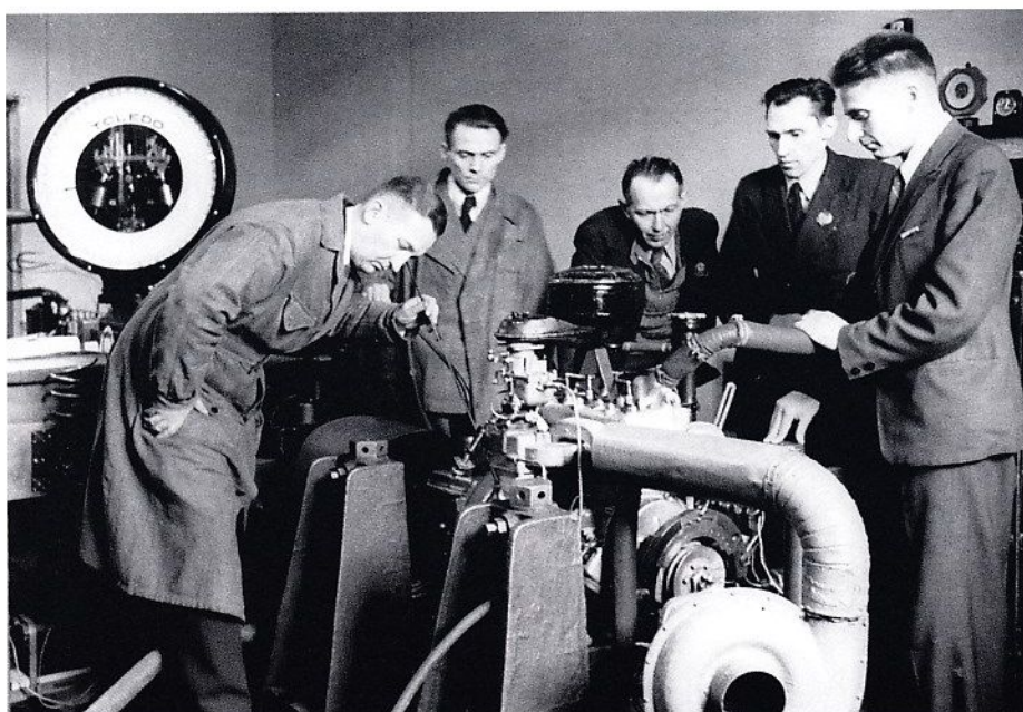
Конструкторы КЭО ГАЗ испытывают новый двигатель на стенде
