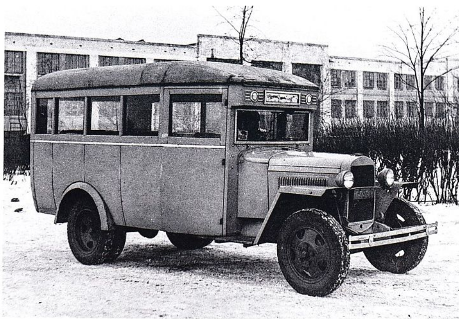
Автобус ГАЗ-03-30 послевоенного выпуска с упрощенными крыльями и фарами уменьшенного размера
