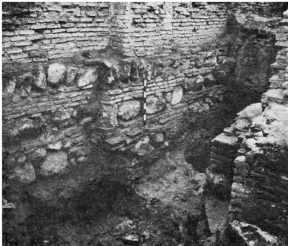
Рис. 4. Южный неф. Уровень верхнего обреза ленточного фундамента
