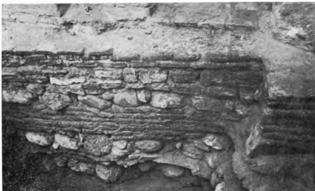
Рис. 6. Выравнивающий ряд плинфы над фундаментом юго-восточного столба
