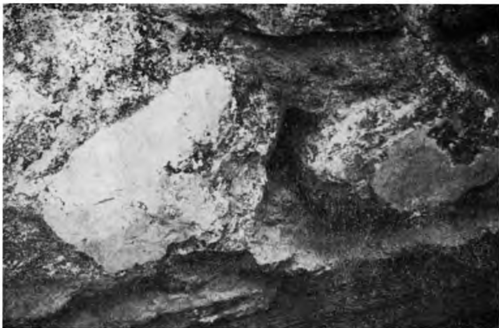
Рис. 5. Бутовый камень вторичного использования с цемяночной затиркой
