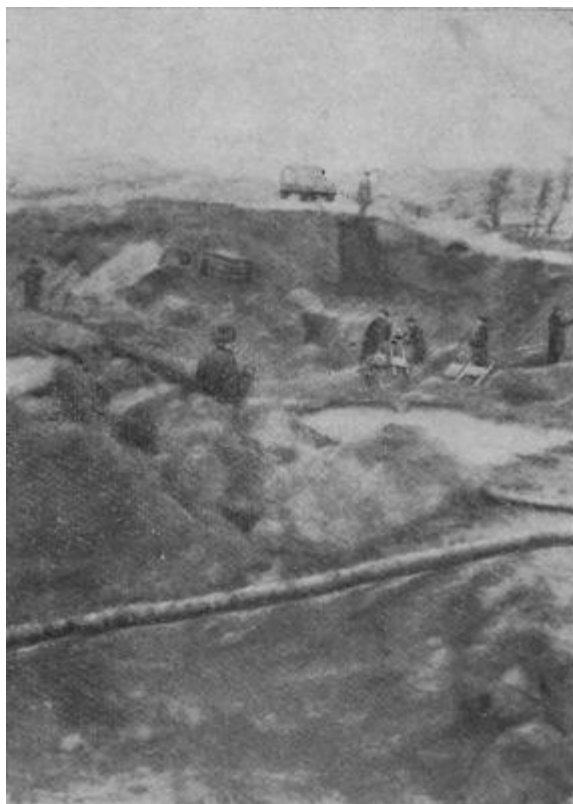
Рис. 31. Воронка на шоссейной дороге, образованная взрывом крупного сосредоточенного заряда ВВ. 1943 г.
