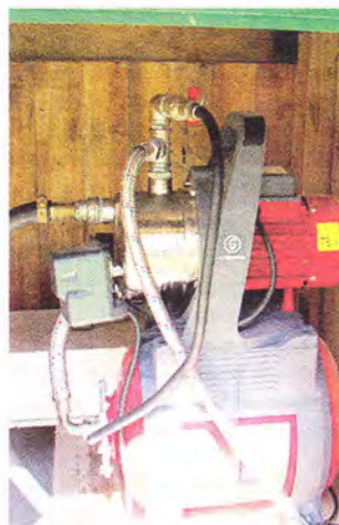
■ Насосная станция на колодце
