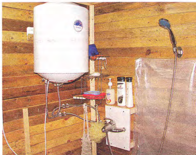
■ Водонагреватель в бане
