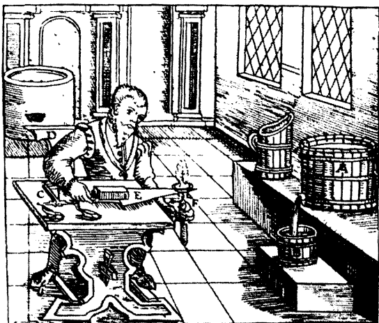
Помещение для определения качества селитры в селитроварне (из книги Л. Эркера, 1574 г.). А — выщелачивание «селитряной земли»; ... С — весы; ... F — выпаривание пробы с помощью свечи.
