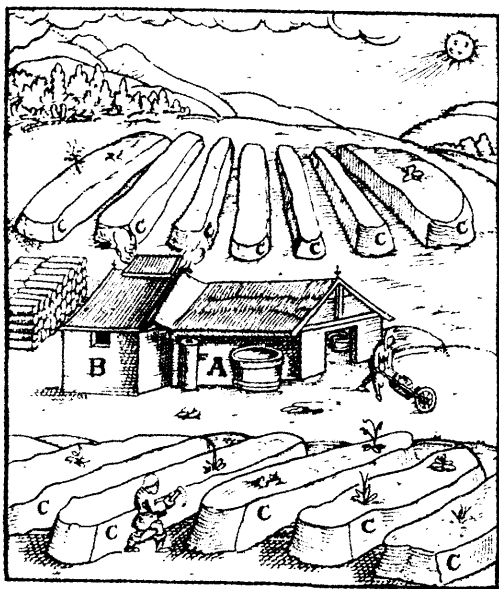
Добыча селитры в XVI в. А, В — варочное отделение выщелачивания земель и выпарки раствора селитры; С — установка для «созревания» различных видов селитры.
