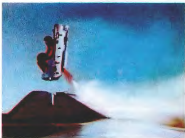
Отработка катапультирования космонавта с корабля «Восток».
