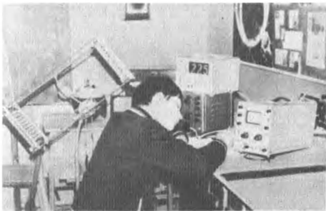
Рис. 3. Регистрация вторичного космического излучения с помощью самодельного телескопа в лаборатории физики космоса Московского городского дворца пионеров.
