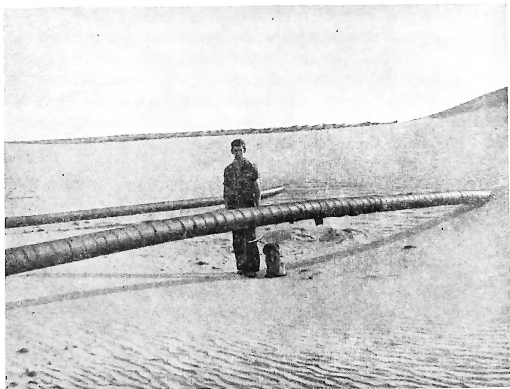
Рис. 14. Выдувание трубопровода
