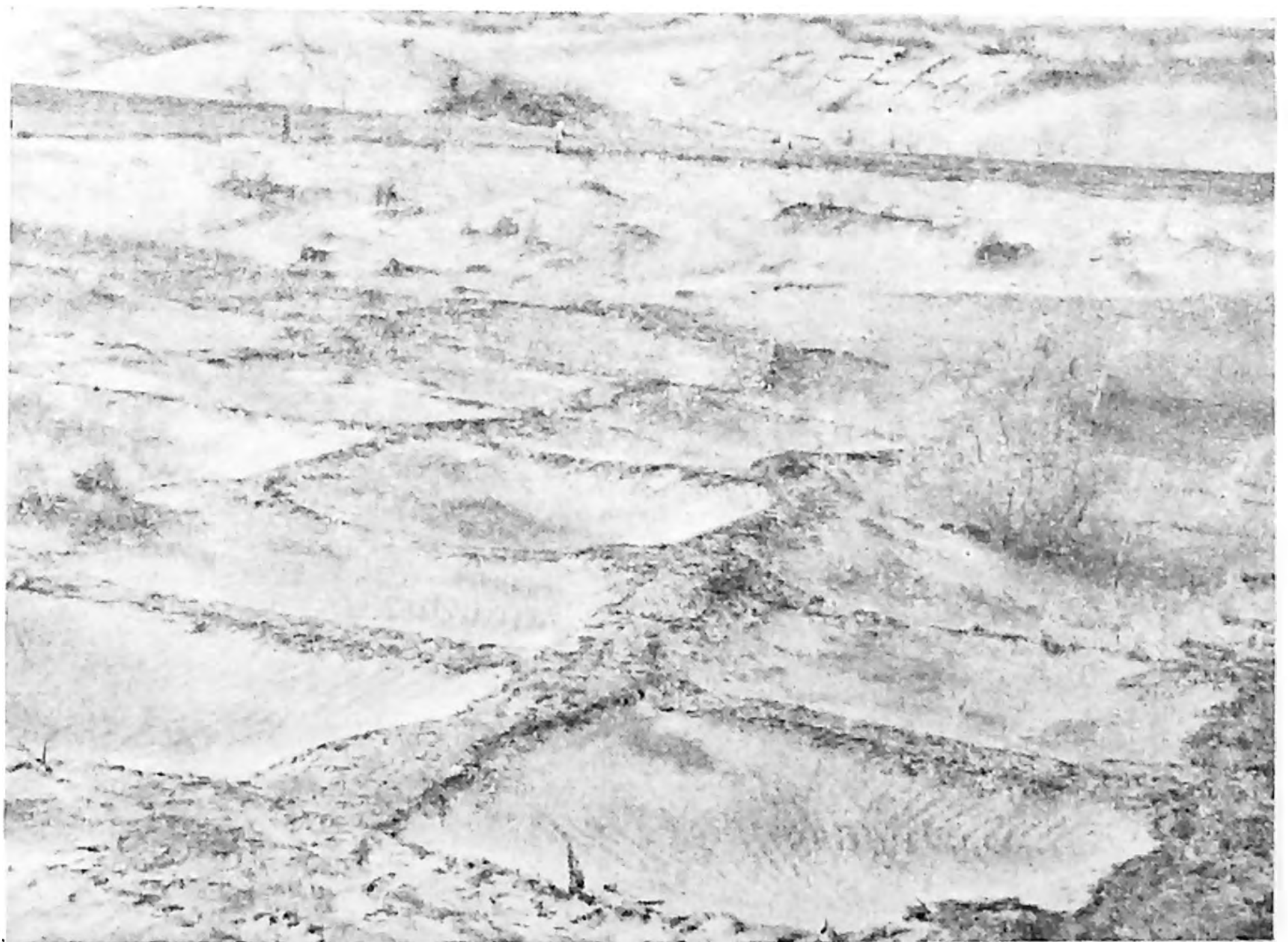
Рис. 20. Клеточная заливка техногенных грунтов нефтью. Фото А. В. Прищепы
