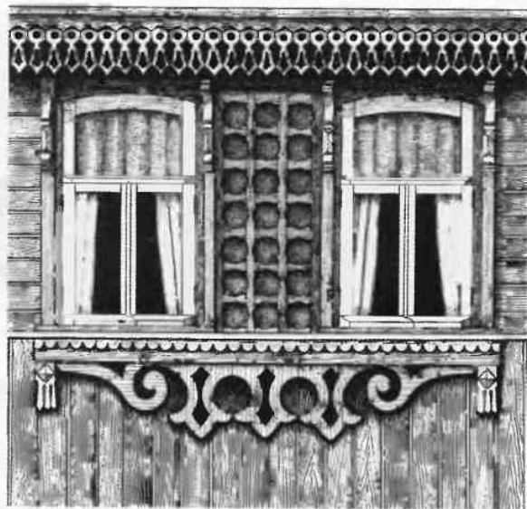
Рис. 235. Оформление окон с использованием вертикально направленных дощечек в орнаменте карниза и подоконника
