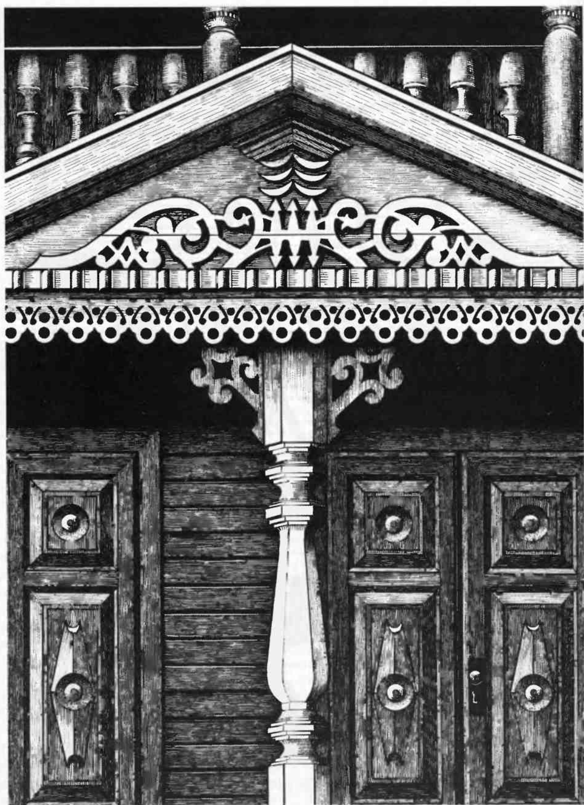
Рис. 234. Резной орнамент на очелье террасы, состыкованный из двух досок и дополненный накладными деталями
